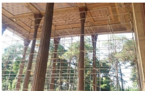
تصویر ۱۳: مرمت سقف چوبی ایوان چهل‌ستون
