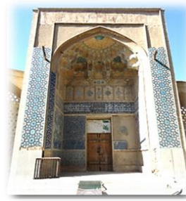
تصویر ۱۰: سر در کاشی‌کاری مسجد قطبیه
